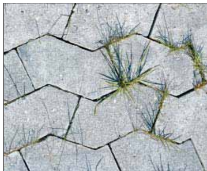
Ældre fyldte fuger har stor resistens mod ukrudt (øverst), mens nye halvtomme fuger giver gode vækstbetingelser for ukrudtet.
