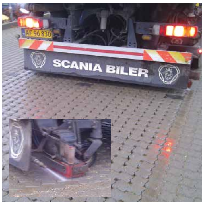
Oprensning af fuger med specialkøretøj.
