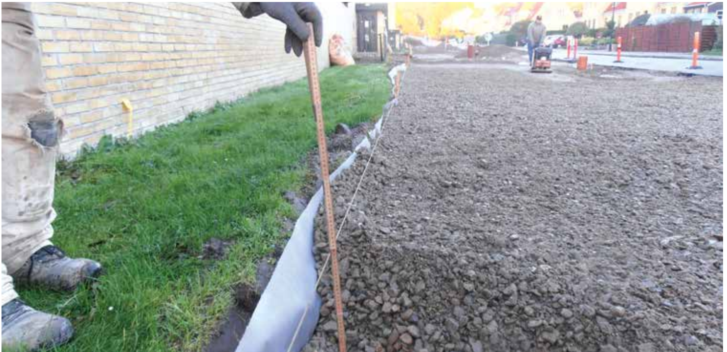
Udlægning af DrænStabil®.
