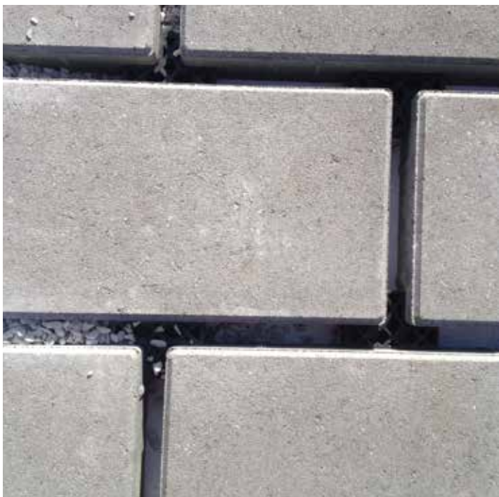
Rektangulære sten med fugekryds, klar til fugefyldning.
