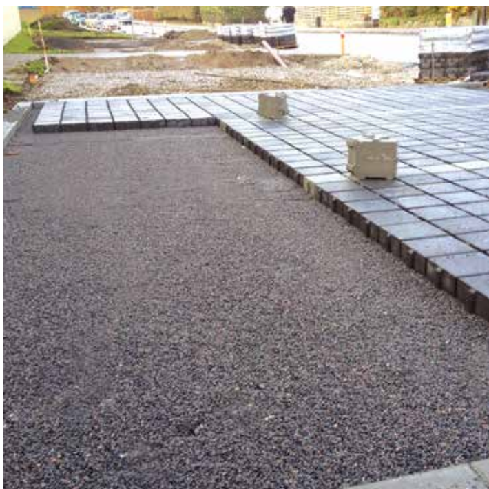
Udlægning af SF-Rima® på DrænAf®.
